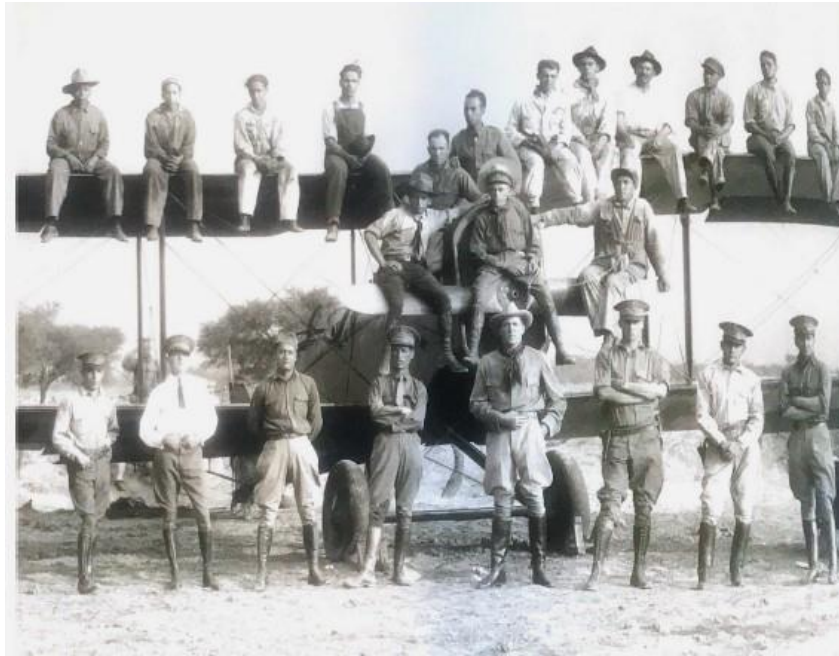
Como una forma de controlar la calidad de los aparatos fabricados en talleres mexicanos, pilotos y técnicos subían a las naves para comprobar su resistencia. Foto recuperada del libro: Centenario de la Industria Militar Mexicana.
